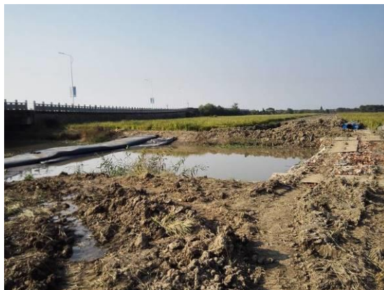
河流大开挖穿越围堰
