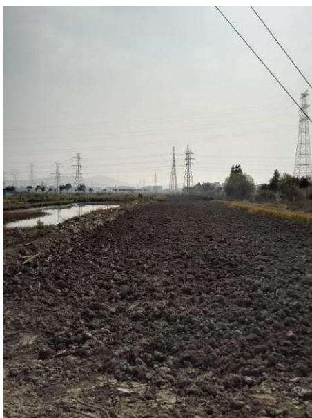
施工作业带回填平整
