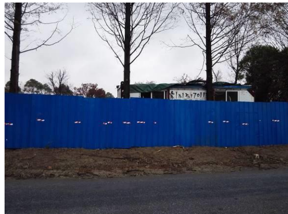
路侧施工场地隔离
