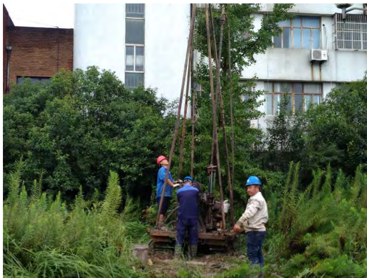
图 3-2 地质勘测人员在操作钻探设备
